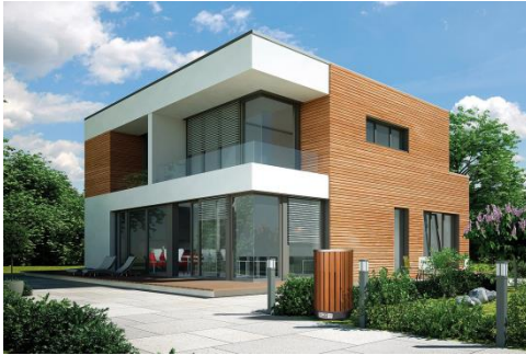
WP im Neubau
